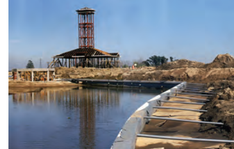
Filtro detrás de muro de contención
