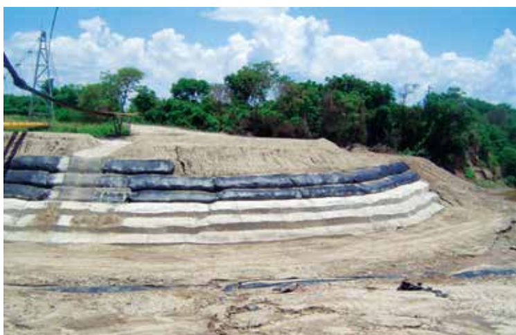
Protección de gasoducto - TGN, Salta
