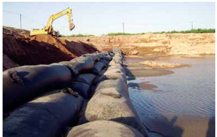
Estabilización de cárcava - Dique Figueroa, Santiago del Estero
