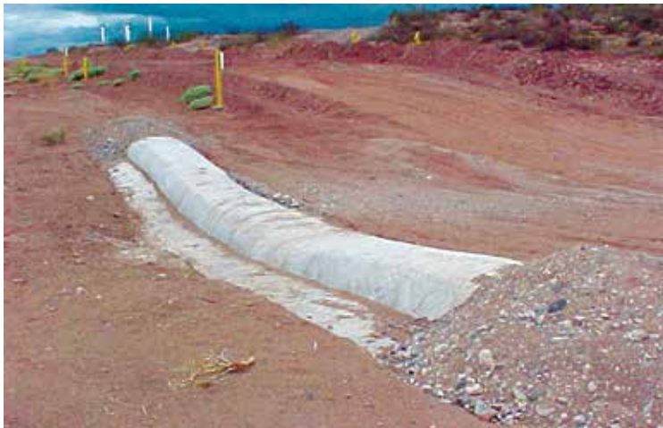
Azud para protección de ductos YPF - Neuquén
