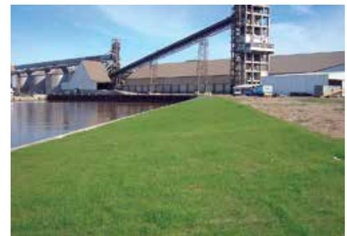
Protección de talud - Terminal Las Palmas - Buenos Aires. Landlok NW 435 + Hidrocobertura.
