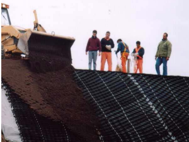
GEOELDAS POSICIONADAS PARA SU RELLENO CON SUELO VEGETAL
