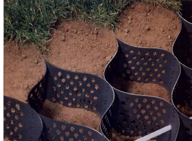
GEOELDAS POSICIONADAS PARA SU RELLENO CON SUELO VEGETAL
