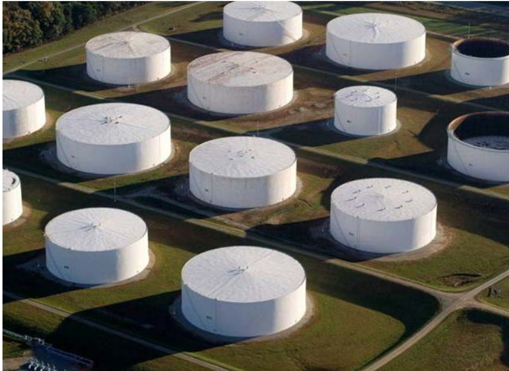
TANKS FARM CON SUS PILETAS DE RECUPERACION GREENSBORO, N.C., U.S.A.
