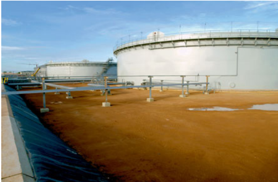
VISTA DE UN TANK FARM EN SAUDI ARAMCO KHURAI, ARABIA SAUDITA
