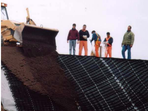
GEOWEB POSICIONADO PARA SU RELLENO CON SUELO VEGETAL
