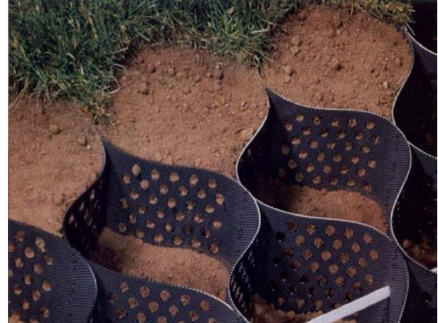
GEOWEB POSICIONADO PARA SU RELLENO CON SUELO VEGETAL
