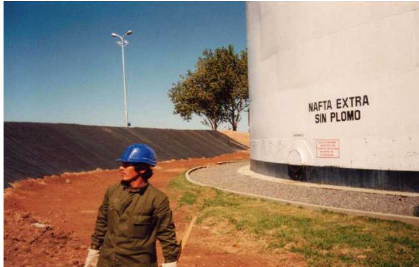
TANQUES DE COMBUSTIBLES – ESSO SAN LORENZO, SANTA FE
