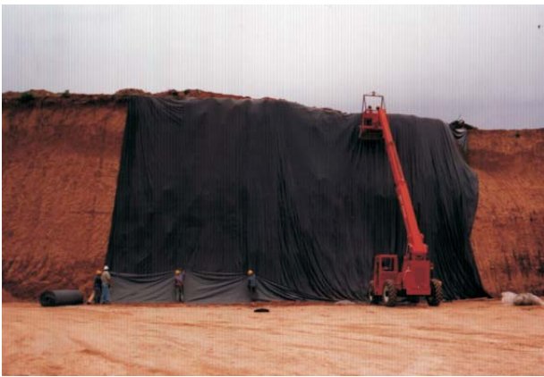
Foto 3: Instalación de la geomembrana FlexPlan en paredes verticales.
