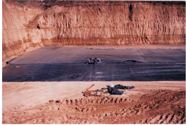
Foto 2: Uniendo paños con soldadura química CHEMITAK .
