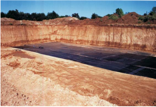
Foto 1: Colocación de la geomembrana FlexPlan en el fondo de la losa.
