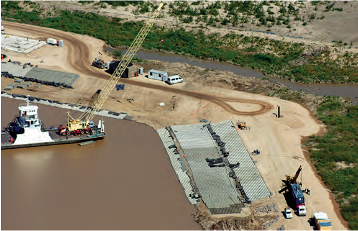
Pto. Gasífero Escobar, Bs As / Geotextil PlusTex + loops (SCL) y pines.
