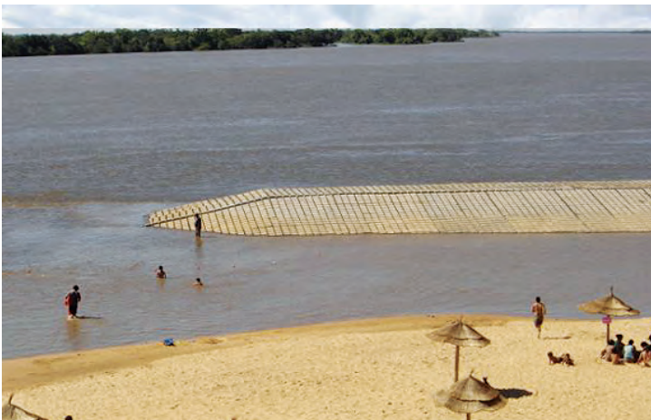
Espigón en río Paraná / Geotextil PlusTex + pines.
