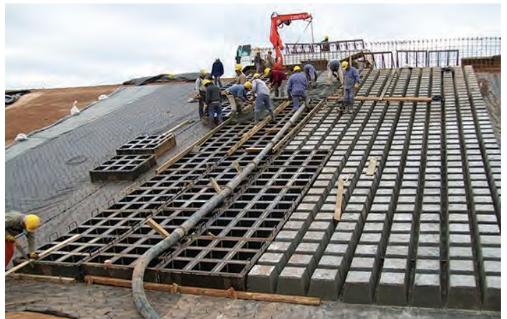
Dique Figueroa - Santiago del Estero / Geotextil PlusTex + pines.
