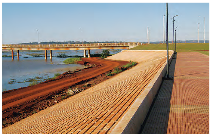
Dique Figueroa - Santiago del Estero / Geotextil PlusTex + pines.
