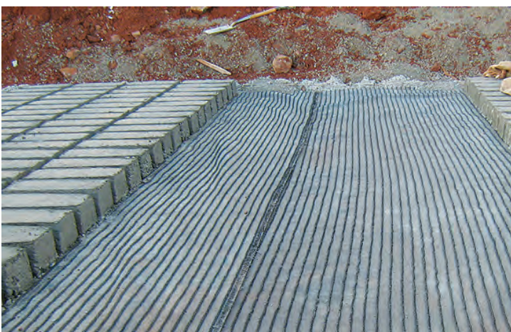
Defensa de Encarnación-Yacyretá, Paraguay / Geotextil PlusTex + loops (SCL)
