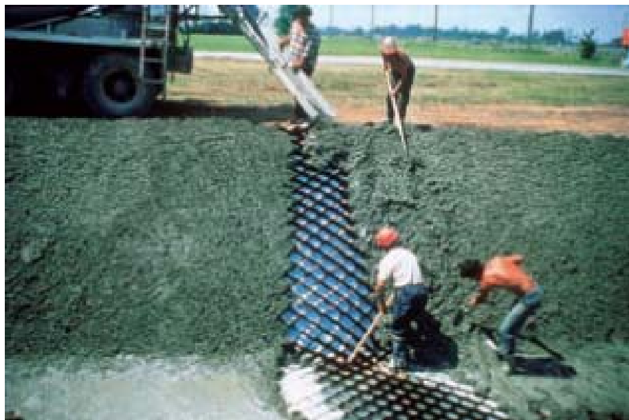
Figura 2. – Llenado de las celdas con hormigón
