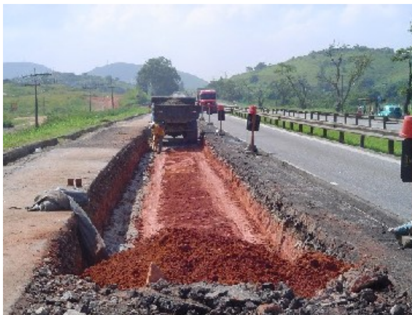
Figura 04 – Execução do dreno profundo..
