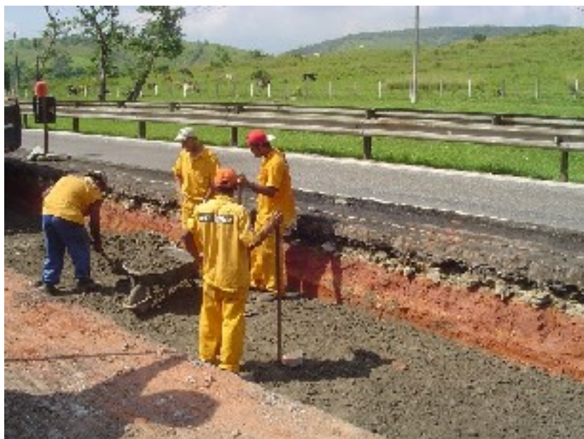
Figura 06 – Execução da primeira camada de BGS.
