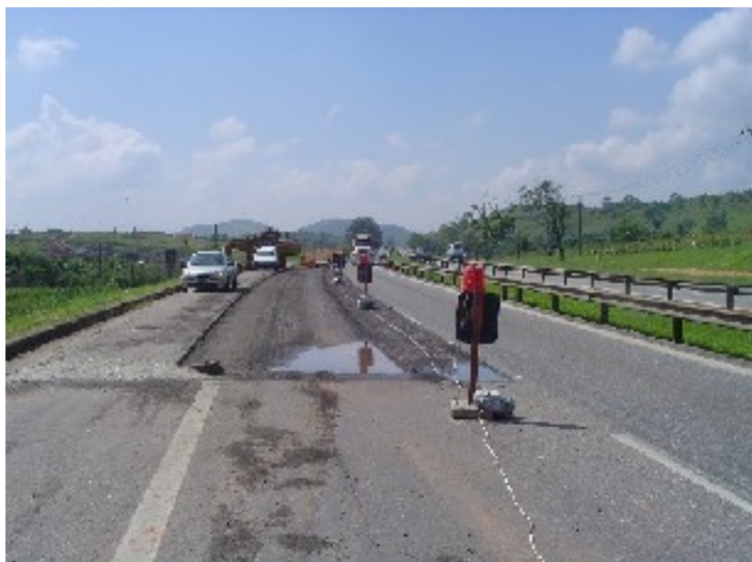
Figura 10 – Execução da camada de PMQ compactada.
