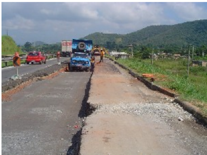
Figura 07 – Vista geral do trecho.
