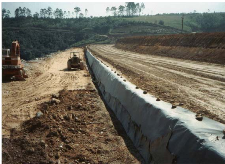
Colocação e fixação do geotêxtil Bidim sobre o perfil do filtro.
