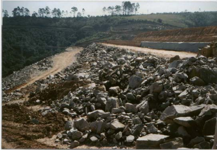
Vista geral do enrocamento e ao fundo a execução do perfil do filtro de transição com o geotêxtil Bidim.
