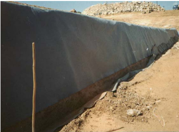
Fixação da manta superior com pedras e a inferior virada sobre o material granular do filtro de transição. Ao fundo a sobreposição com costura manual.
