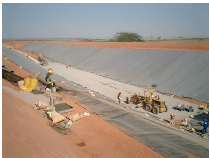
Vista geral da execução do colchão drenante.
