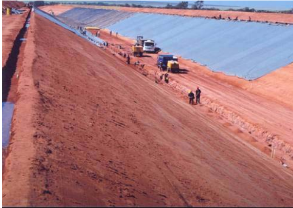
Escavação da trincheira drenante no pé do talude esquerdo.
