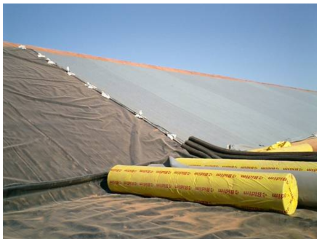
Bobinas de Bidim e tubos para drenagem.
