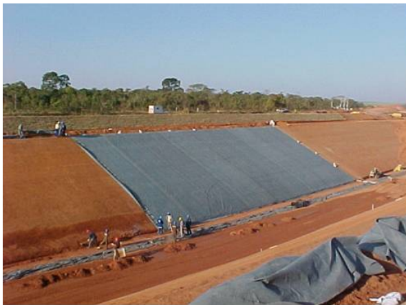
Execução da trincheira drenante no pé do talude.
