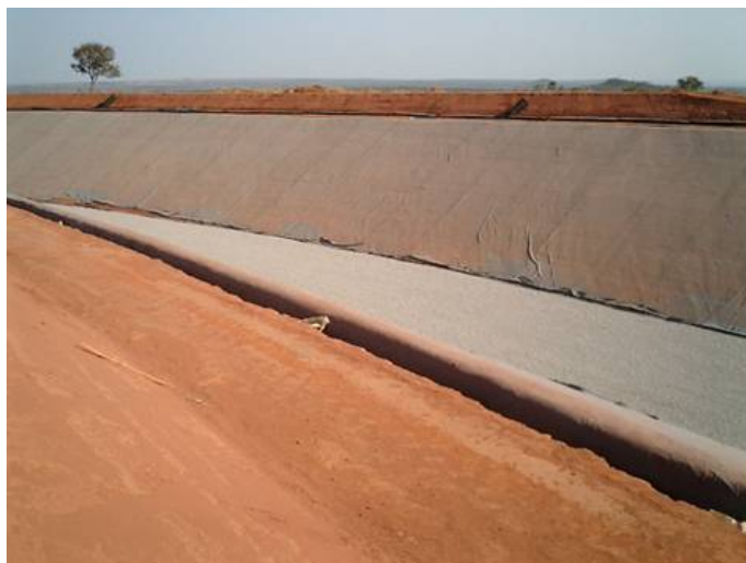
Colchão drenante concluído.
