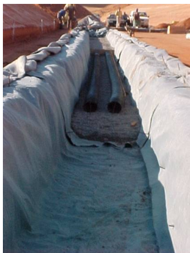
Detalhe da trincheira drenante com dois tubos flexíveis perfurados para drenagem.
