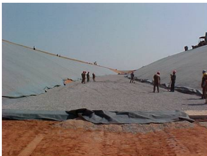
Detalhe da execução do colchão drenante.
