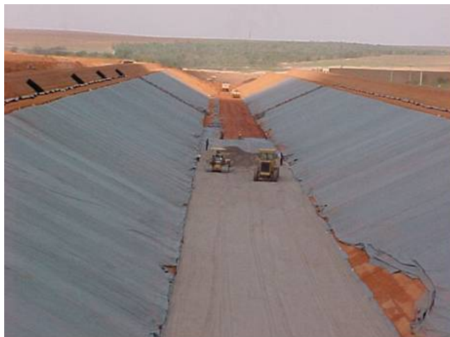
Vista da execução do colchão drenante.
