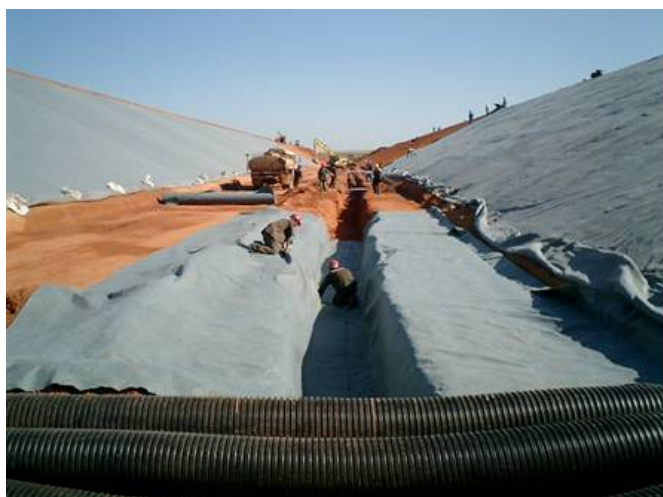
Instalação do Bidim na trincheira drenante.
