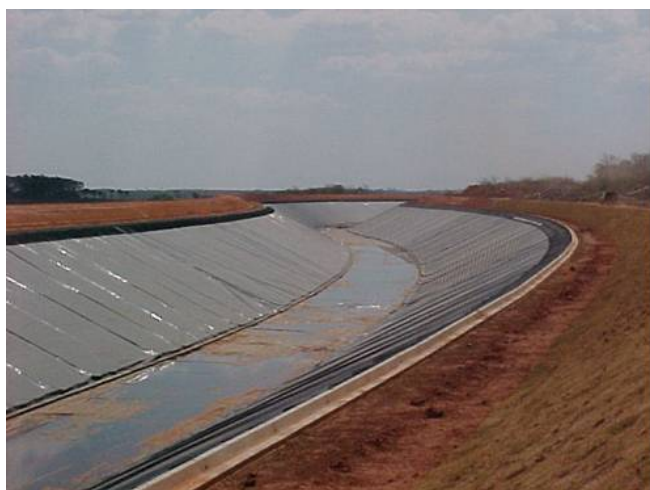
Vista do canal concluído.
