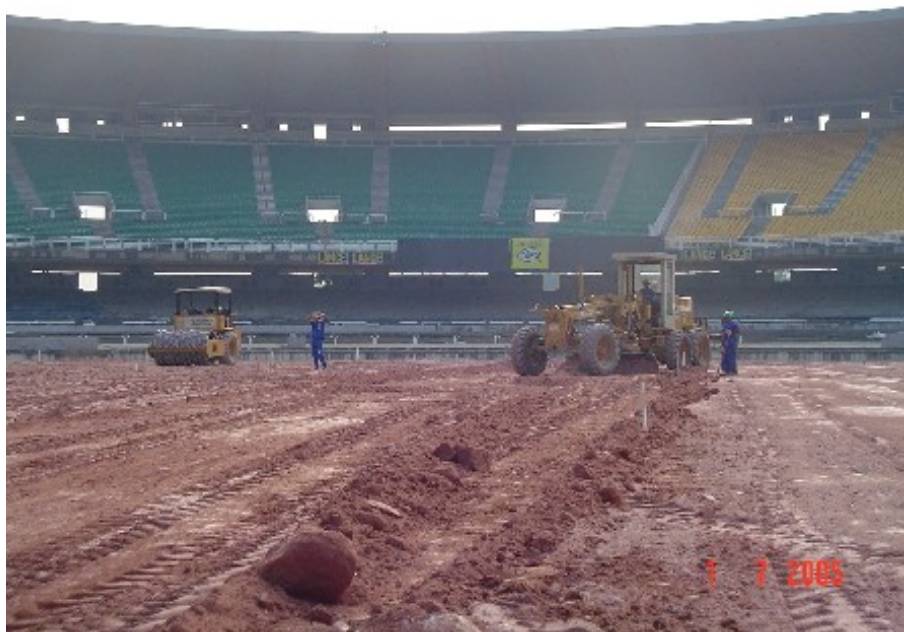
Figura 04 – Preparação do terreno para a execução da drenagem.
