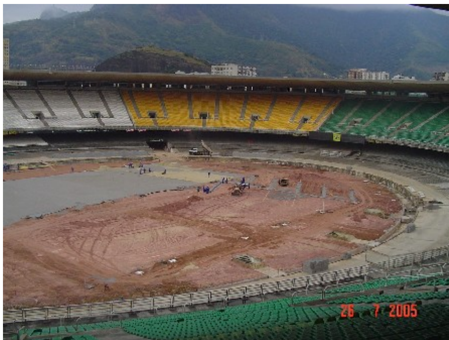
Figura 08 – Vista geral do campo.
