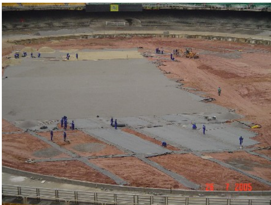
Figura 09 – Vista geral do campo com a execução da camada de Bidim.
