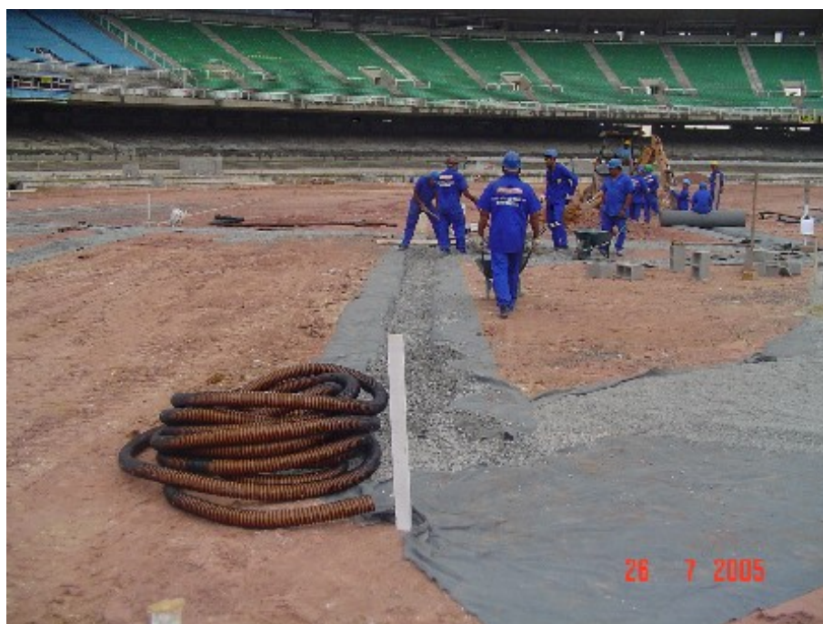
Figura 07 – Detalhe da trincheira drenante.
