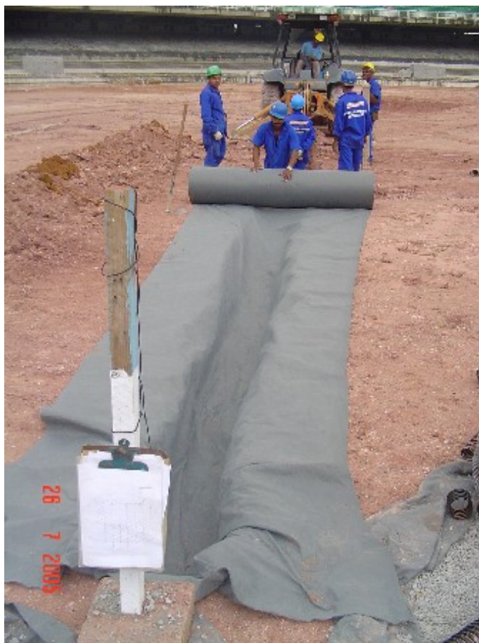
Figura 06 – Detalhe da colocação do Bidim.
