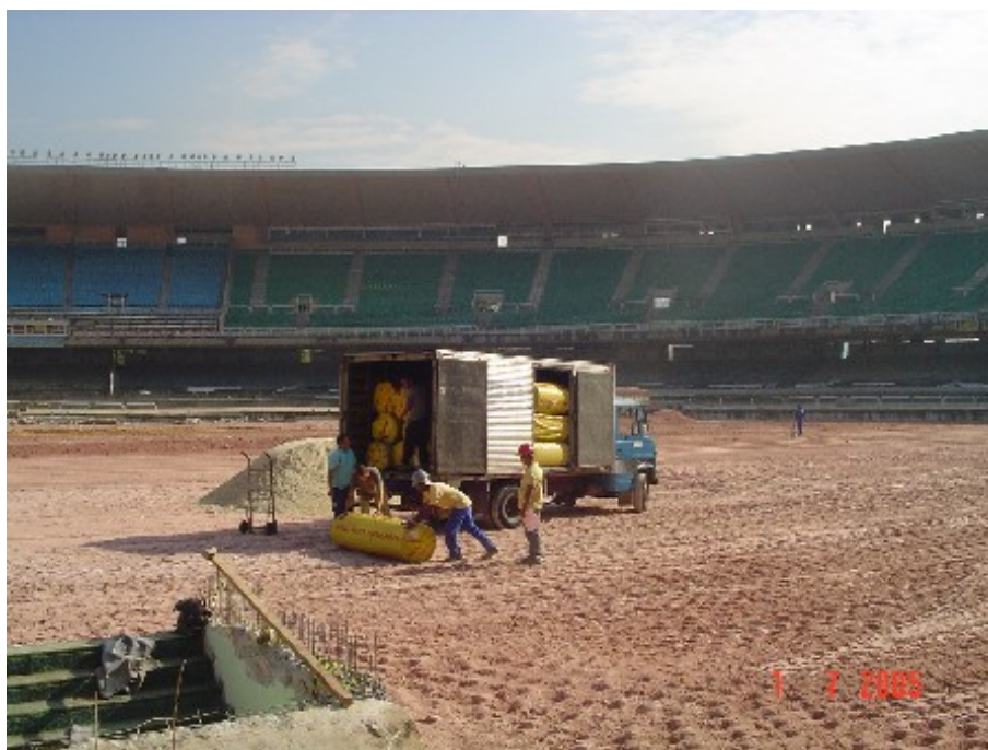
Figura 05 – Descarregamento das bobinas de Bidim RT-10.
