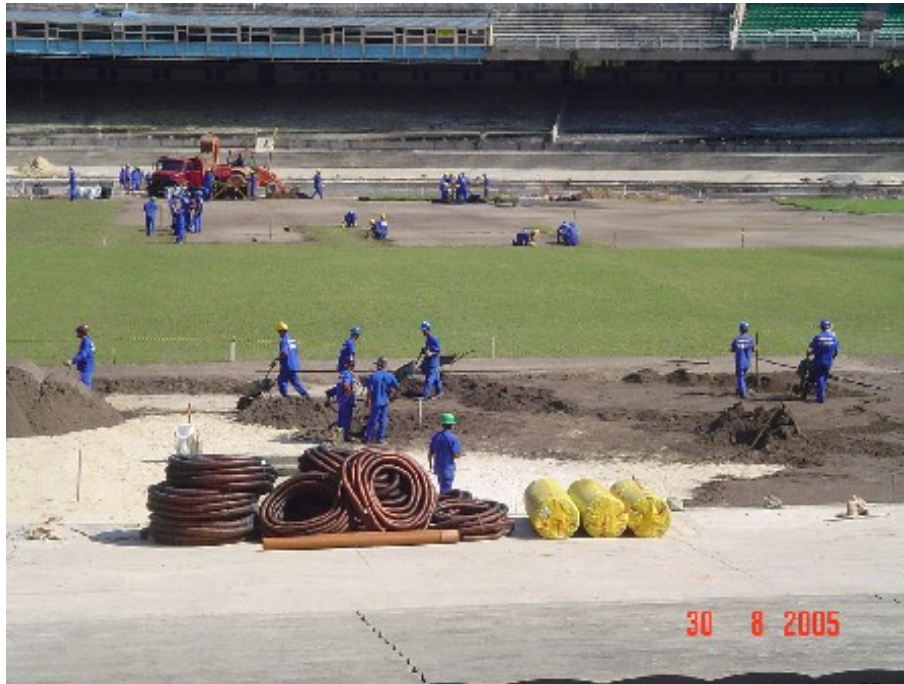
Figura 10 – Vista geral do campo em fase de finalização.
