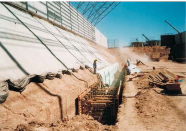
Foto 5: Detalle de impermeabilización del túnel de descarga.
