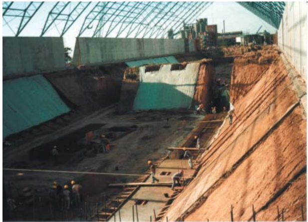
Foto 6: Vista general de la obra.
