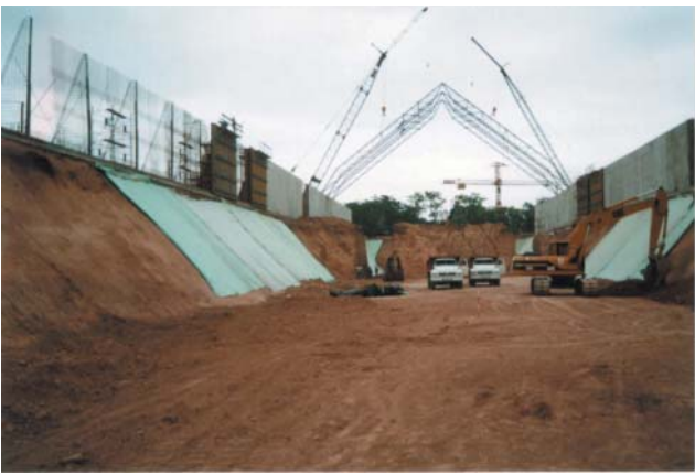
Foto 3: Vista general de la obra.
