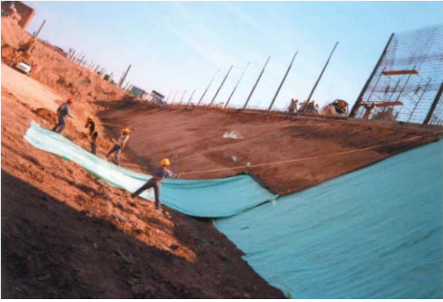
Foto 1: Izamiento de los paños sobre taludes laterales.
