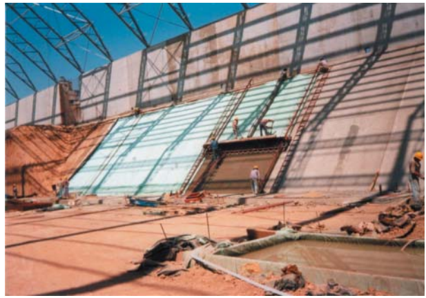
Foto 4: Hormigonado de paños (encofrado deslizable).
