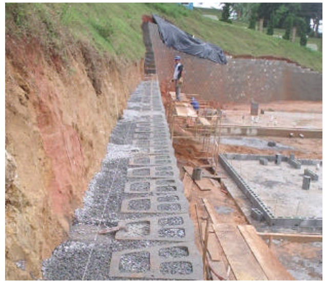
Vista de uma obra com grampos concretados.
