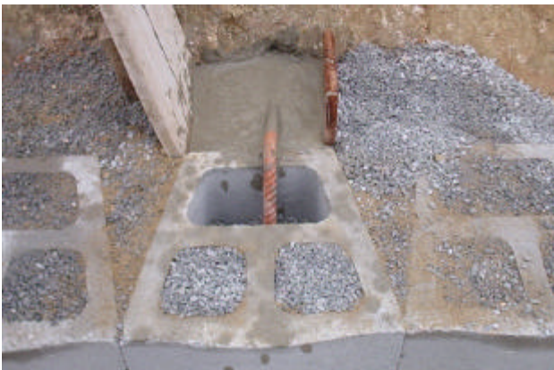
Concretagem junto ao corte.
