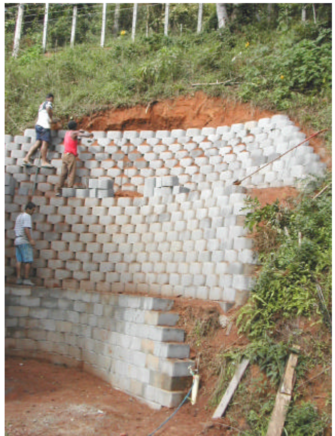
Solo grampeado em Araras, Petrópolis, RJ. Altura de 5,4m.
