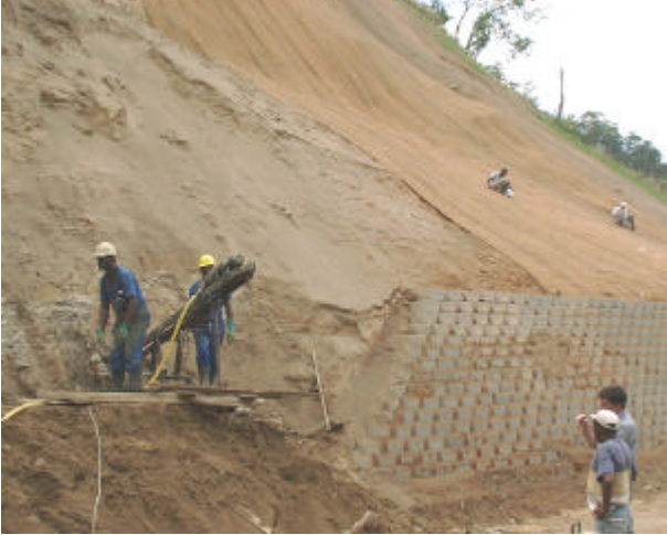
Solo grampeado na Indústria Crown, Paracambi, RJ Detalhe da Perfutariz e do paramento.
