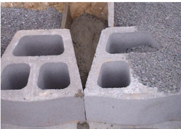
Colocação dos blocos acima do grampo e concretagem final.
