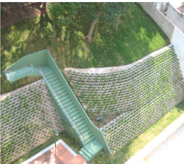
Solo grampeado no empreendimento Residências do Bosque, Rua Vereador Duque Estrada, Niterói, RJ. Altura de 6,0m.
