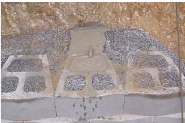
Concretagem no bloco
