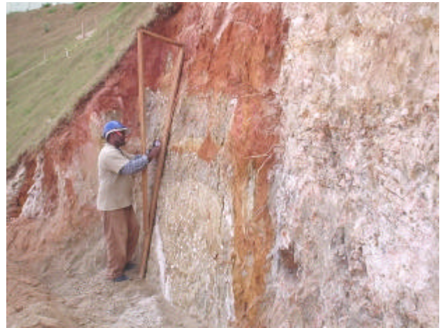
Corte executado com gabarito.
