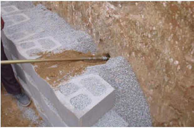
Detalhe da perfuração com trado manual.
