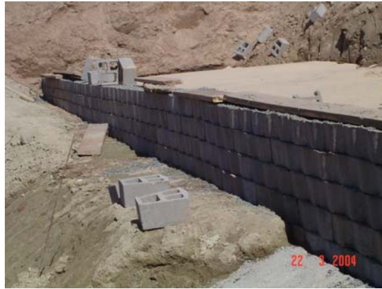
Fig. 10 – Inicio de la Elevación del Muro
