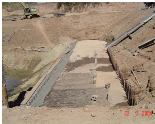
Fig. 9 – Geogrillas y Relleno con Arena Refulada
