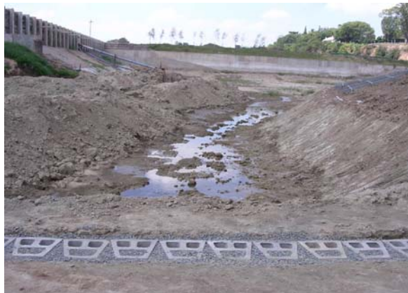
Fig. 8 – Fundación del muro
