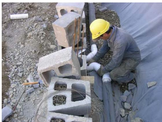
**Fig. 9: Colocación dren posterior**
