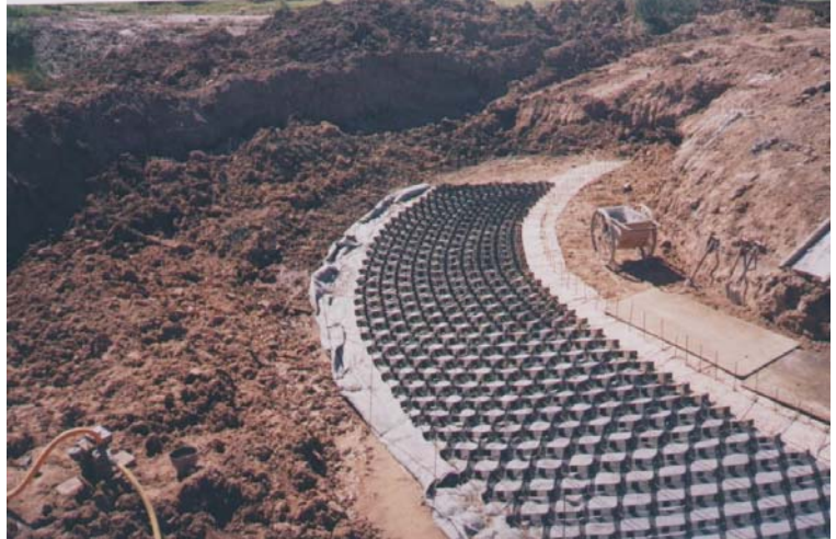
Puente sobre el Río Salado - Santa Fe - Argentina
