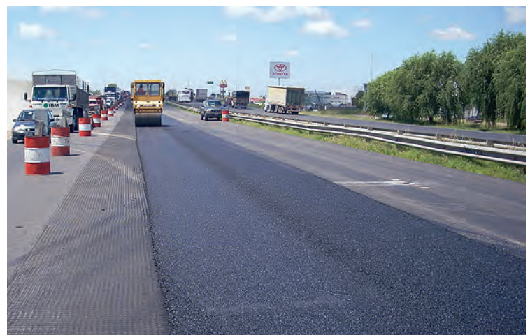
Repavimentación RN 9 - Cruce de Campana. Hatelit C 40-17.
