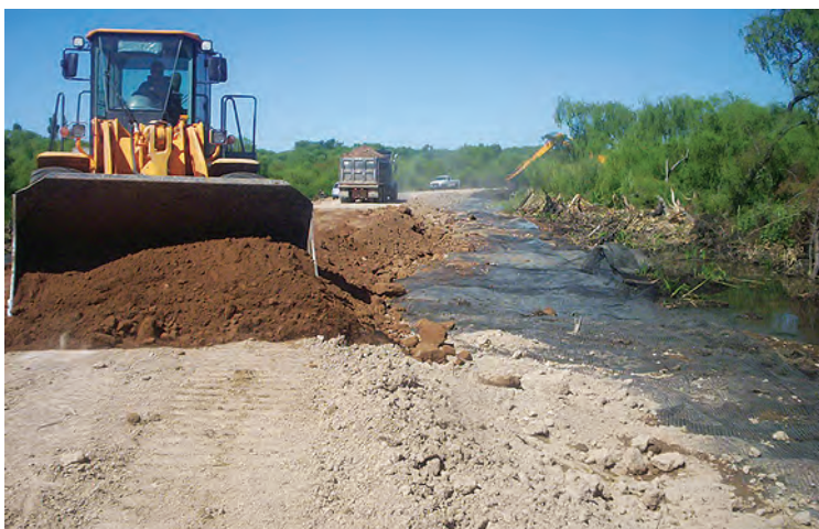
Repavimentación RN 9 - Cruce de Campana. Hatelit C 40-17.
