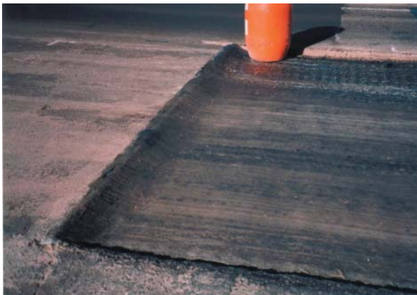
Foto 5: Nótese la flexibilidad del geotextil que le permite copiar las irregularidades del fresado.
