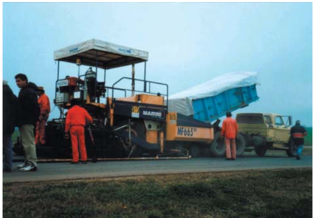
Foto 6: Colocación de la nueva carpeta de rodamiento.
