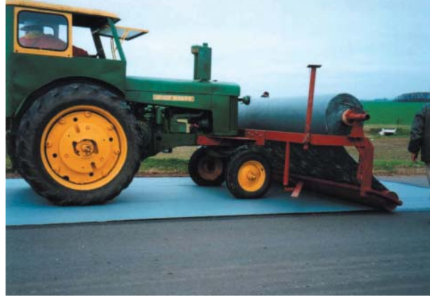
Foto 2: Instalación del geotextil con un bastidor de empuje.
