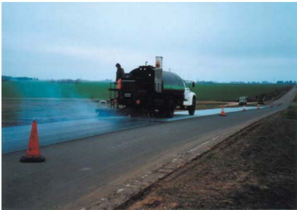
Foto 3: Segundo riego de cemento asfáltico en caliente.
