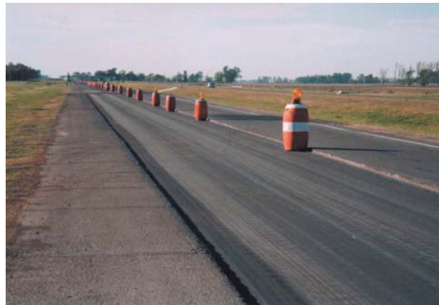
Foto 4: Geotextil extendido y con ambos riegos aplicados.
