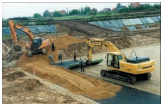
Instalación de Fortrac ® R 1200/100-10 AM
