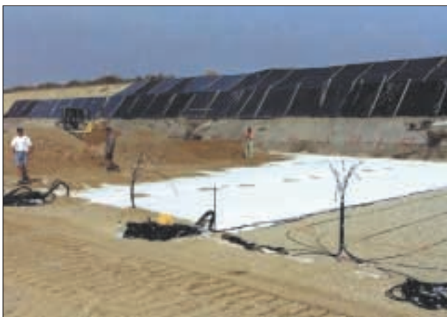
Instalación de una capa de aviso y de un sistema de monitorización
