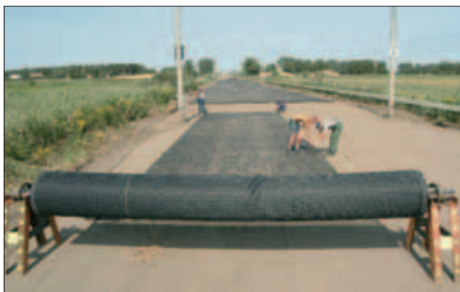
Mecanismo de desenrollado y corte de la geomalla
