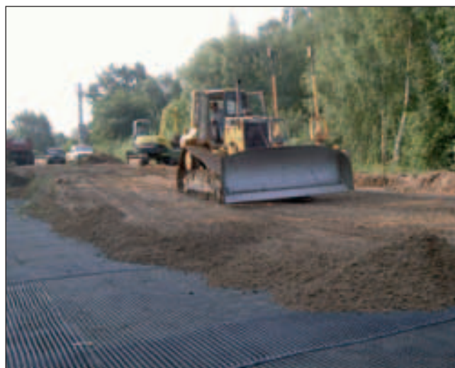
Extendido sobre la geomalla. Se observa el solape de 1 m entre paños de geomalla.
