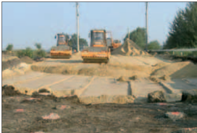
Extendido de las capas granulares. Se observan las cabezas de los pilotes cortadas al mismo nivel.
