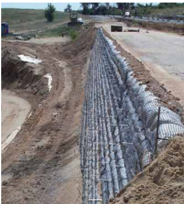
Macizo de suelo reforzado utilizando sacos de arena
