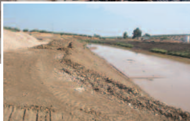
Vista general de la obra antes de la instalación de Incomat®
