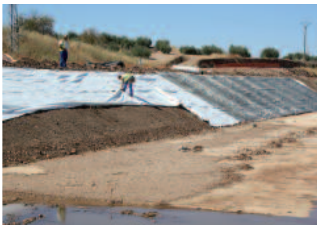
Extendido de geotextil no tejido y panel de Incomat® Flex
