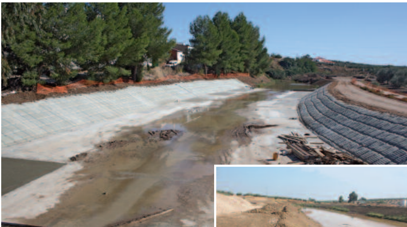
Vista general de la obra tras instalación de Incomat®
