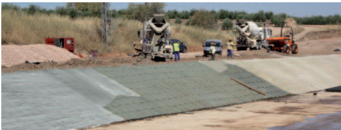
Instalación de Incomat® Flex
