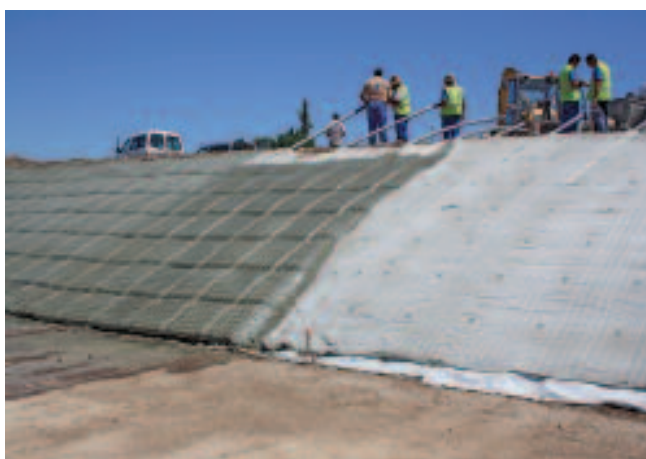
Llenado de Incomat® Flex con hormigón con finos
