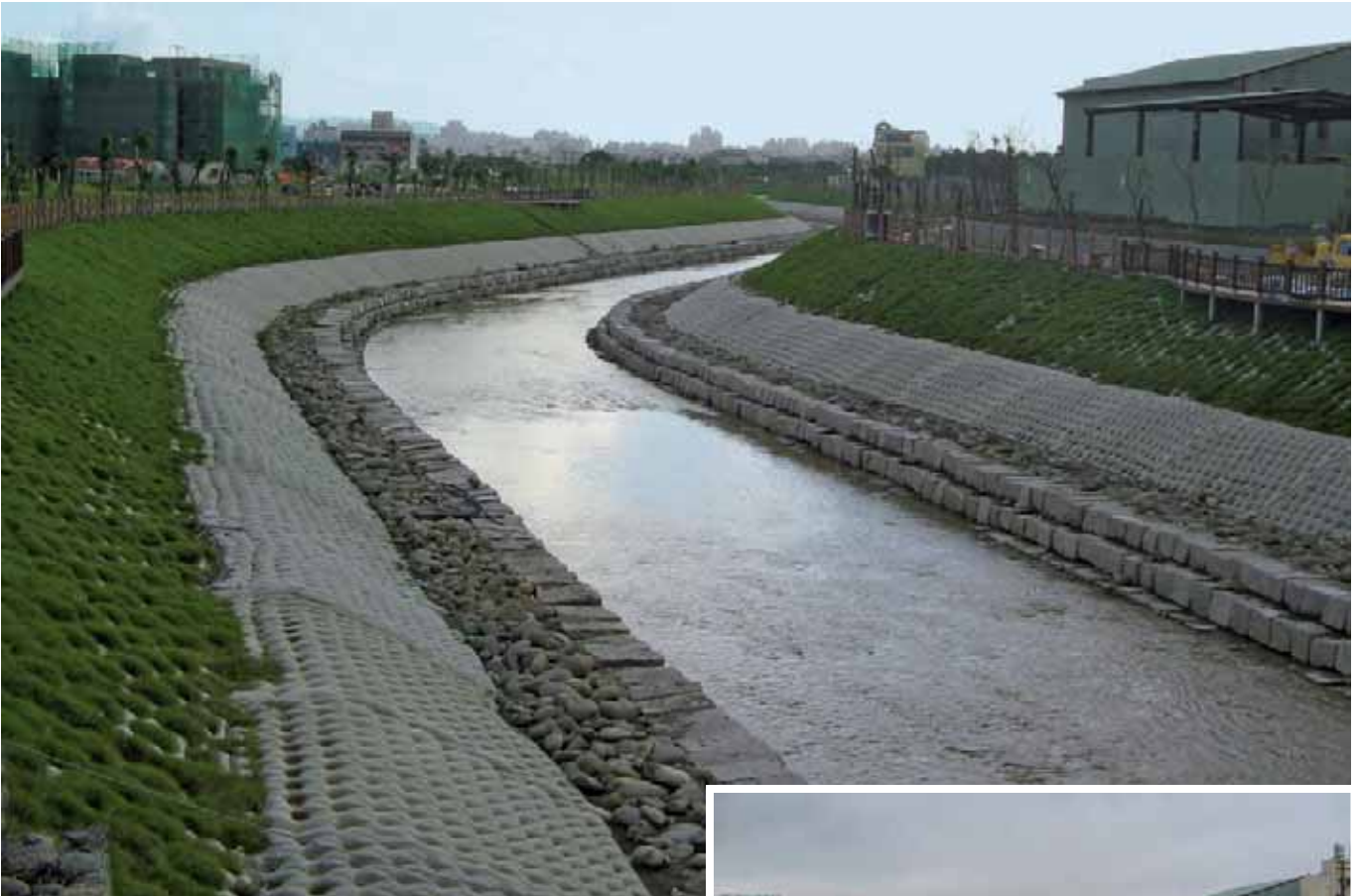
Canal recién construido
