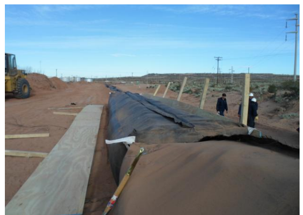
Fig. 6. Retiro de encofrados
