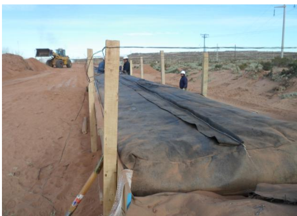
Fig. 5. Geotubos encofrados
