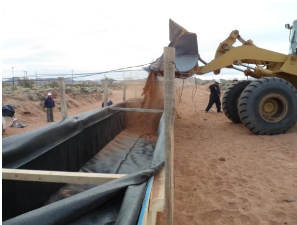
Fig. 3. Llenado con pala cargadora
