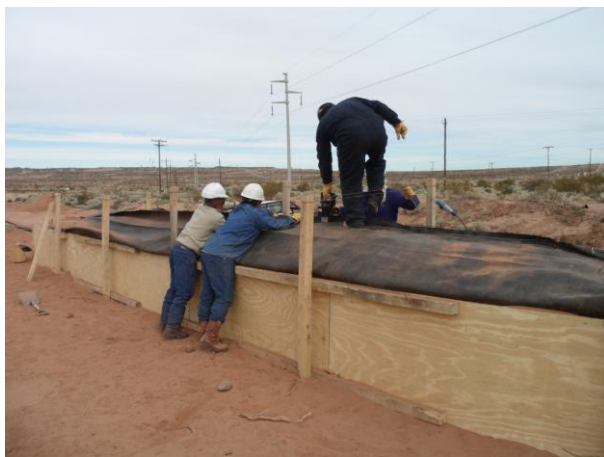
Fig. 7. Costura con máquina portátil
