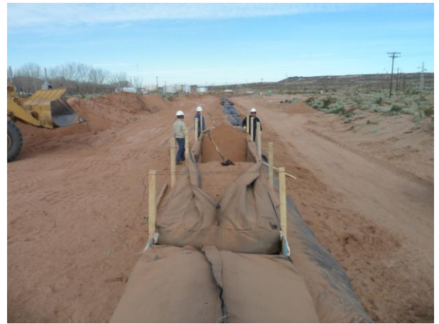
Fig. 4. Acomodo y compactación manual
