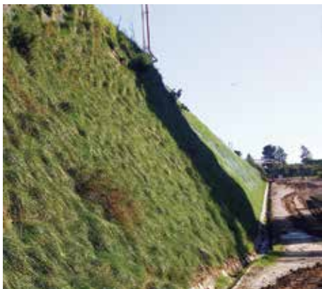
Protección de barrancas
