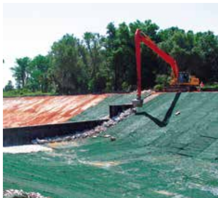
Revestimiento de canales
