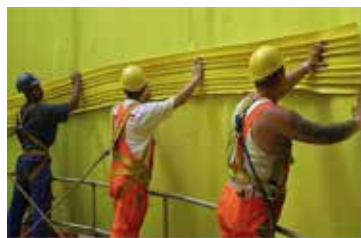
Impermeabilización de pozo de ventilación
