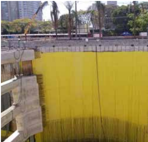
Impermeabilización de pozo de ventilación
