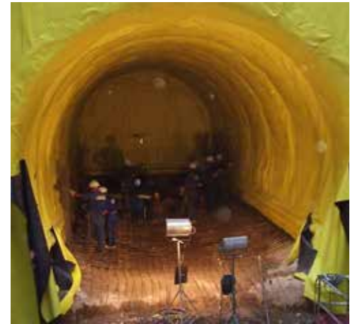
Impermeabilización de túnel.
