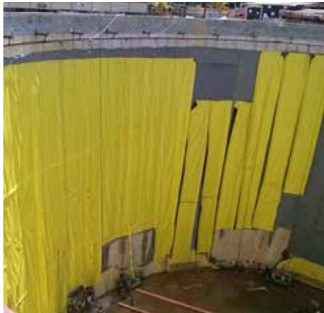
Impermeabilización de pozo de ventilación.
