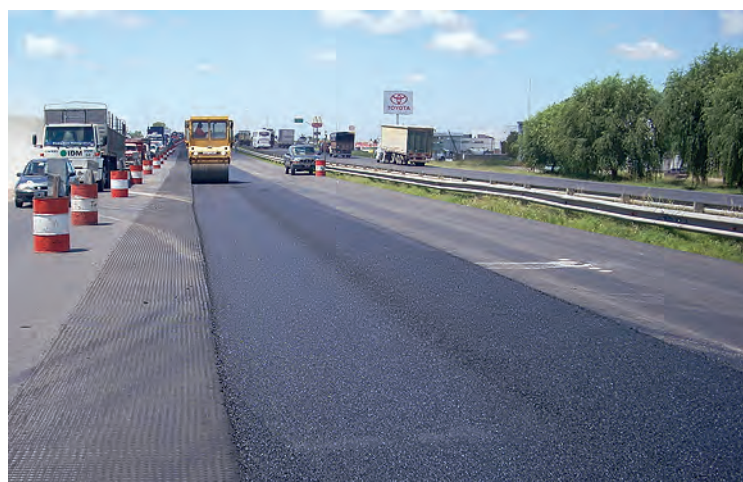
Repavimentación RN 9 - Cruce de Campana. Hatelit C 40-17.
