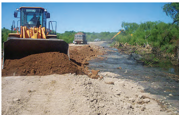
Refuerzo de Terraplen sobre suelo blando - Berisso, Pcia. Bs. As.
