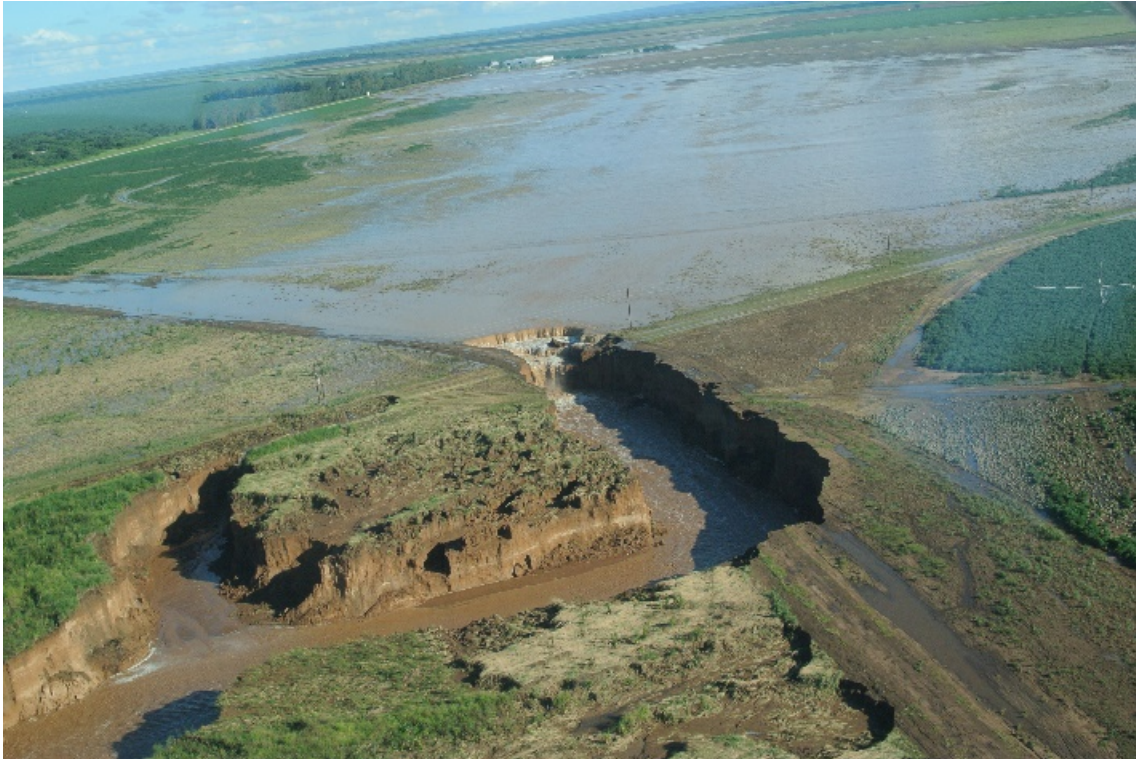
Figura 2.- Ejemplo de cárcavas generadas en la zona por la erosión del agua
