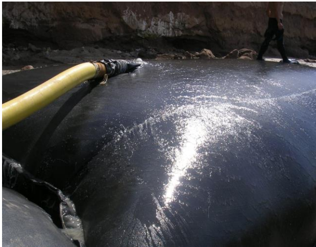
Fig. 3. Llenado mediante bomba
