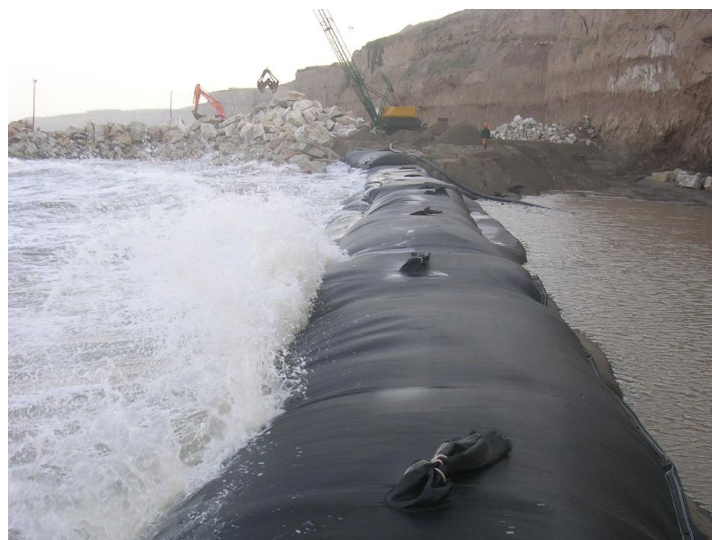
Fig. 5. Disposición lineal de GeoTubos® RH
