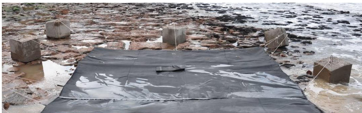
Fig. 2. Alineación y anclaje del GeoTubo® RH
