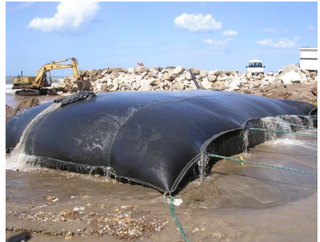
Fig. 4. Finalización de operación de llenado
