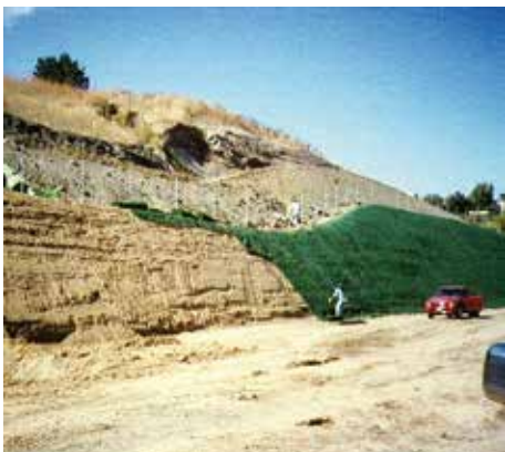
Protección de taludes erosionables
