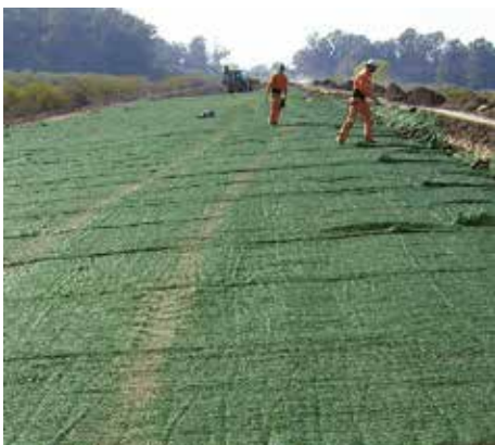
Protección de superficies erosionables
