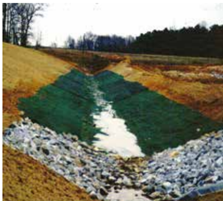
Revestimiento de cunetas y cañadas
