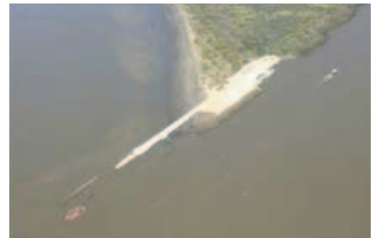
Foto aerea de ubicación de la escollera
