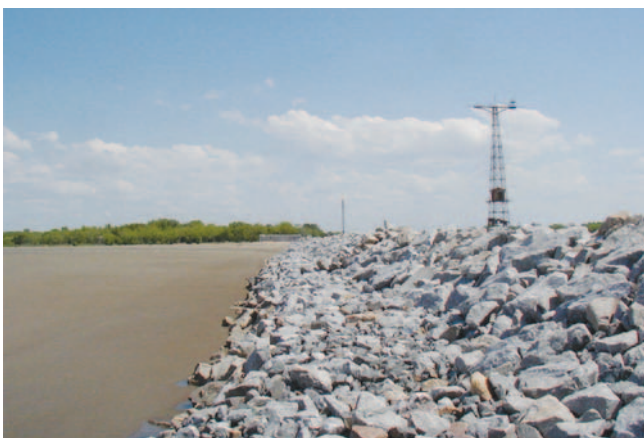
Subcapa de rocas de hasta 340 Kg.
