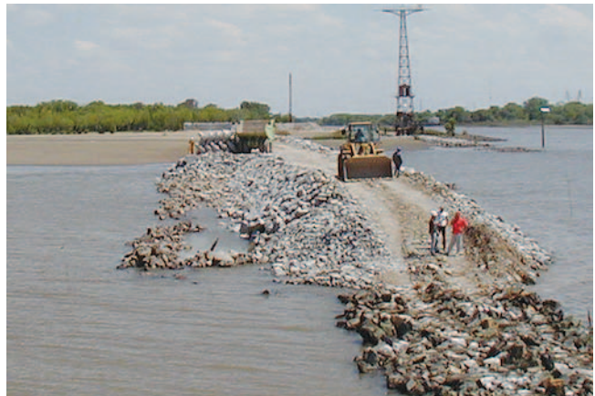
Carga de piedras del núcleo.
