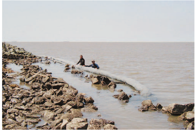
Posicionado del geotextil Bidim RT-31 enrollado.
