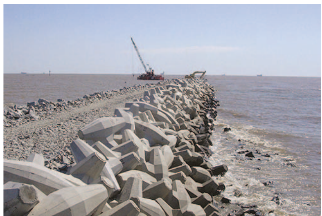
Coraza de tetrápodos - bloques premoldeados de H°
