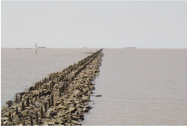
Estado inicial de la escollera existente.
