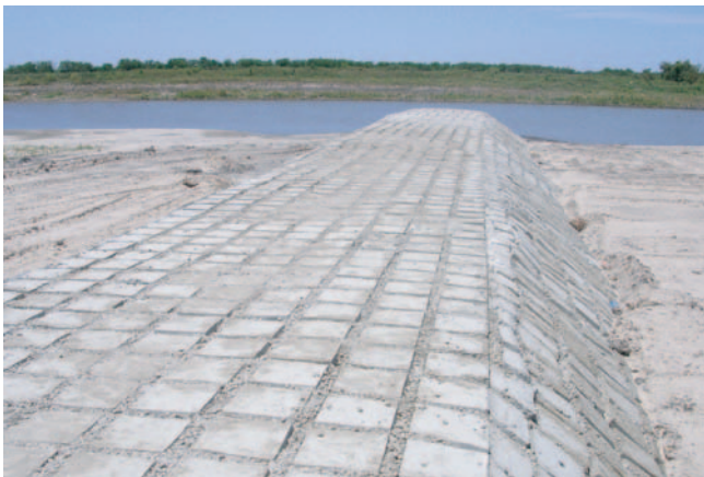
Vista del revestimiento de un espigón
