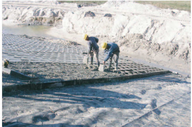
Hormigonado in situ de los bloques
