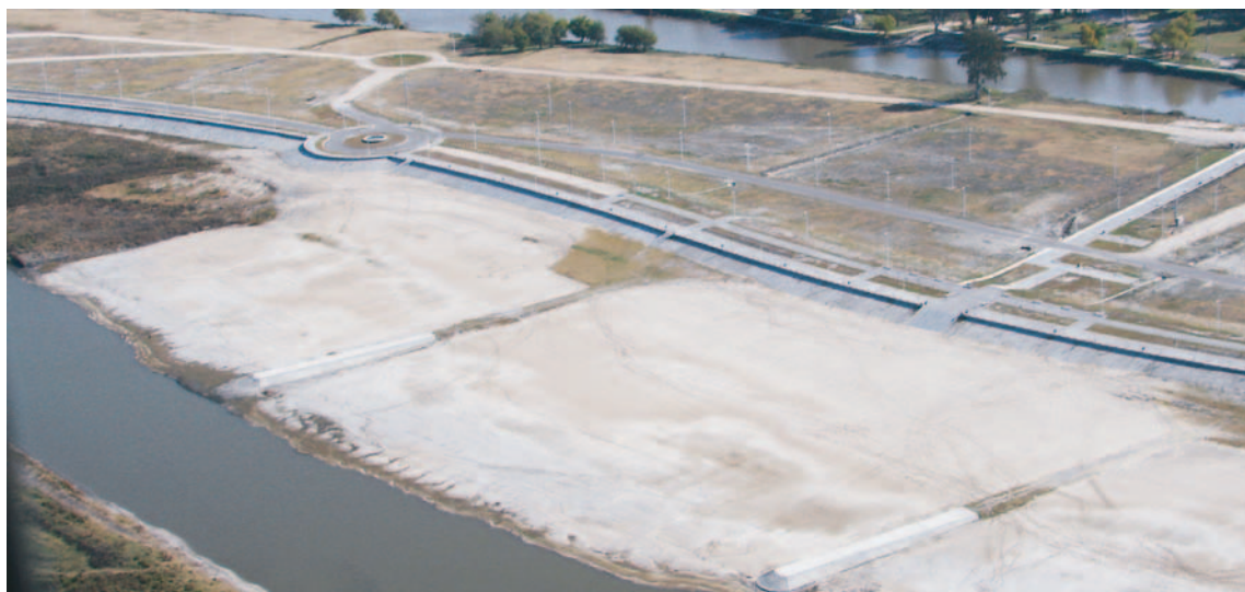
Vista aérea central de la obra.
