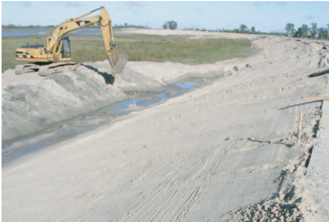
Perfilado del talud exterior del terraplén
