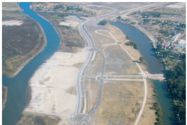
Vista general de la obra
