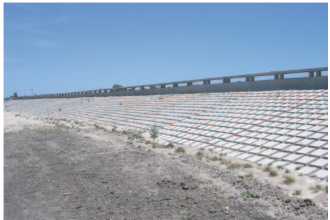
Vista del talud ya revestido
