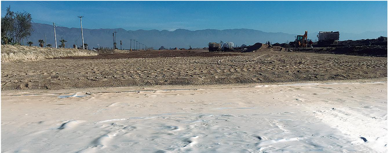
Vista general del geotextil con el material relleno
