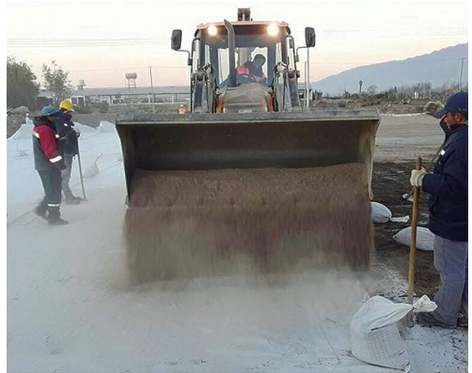
Colocación del material de relleno del terraplén sobre el geotextil.
