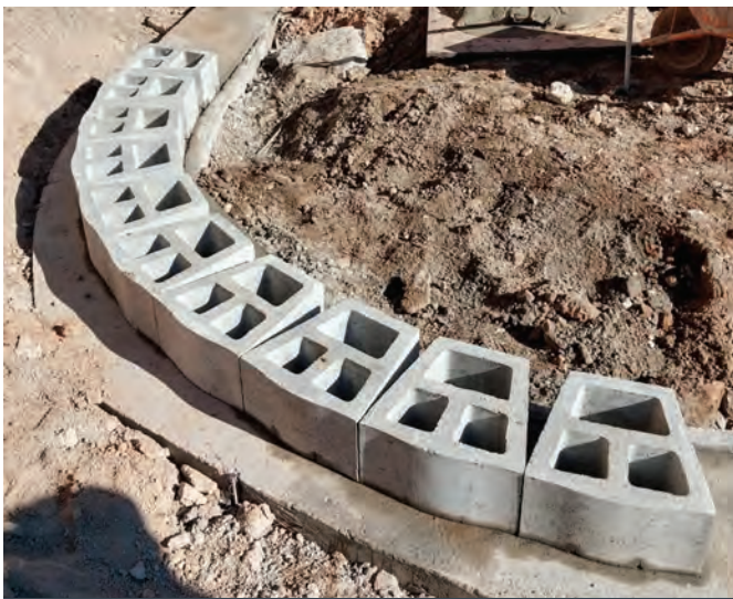
Fundación y ejecución de curvas.
