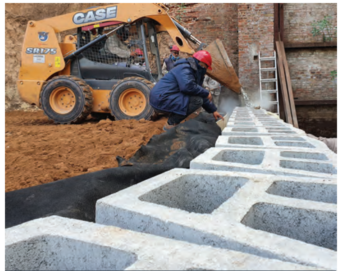
Relleno posterior y sistema de drenaje.
