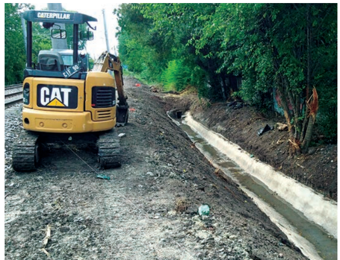
El CC5 comienza a fraguar y el canal queda en servicio
