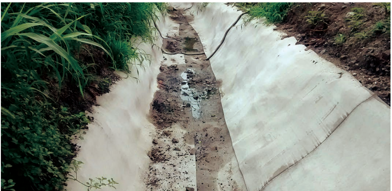
Obra finalizada (vista al mes de terminada).
