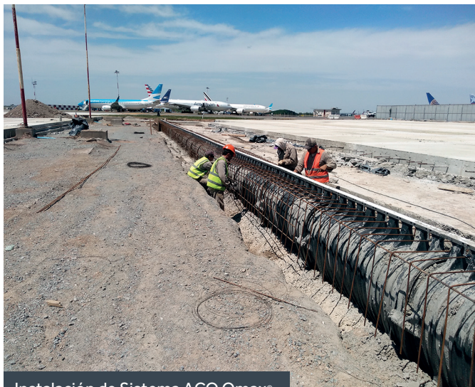
Instalación de Sistema ACO Qmax®
