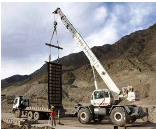
Izaje de mantas para inicio de montaje
