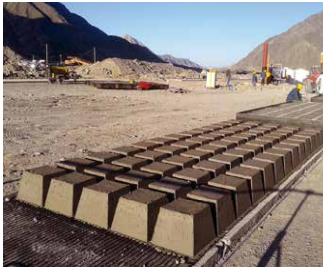
Hormigonado de mantas BetonFlex®
