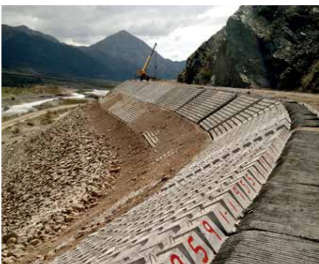
Avance de la obra
