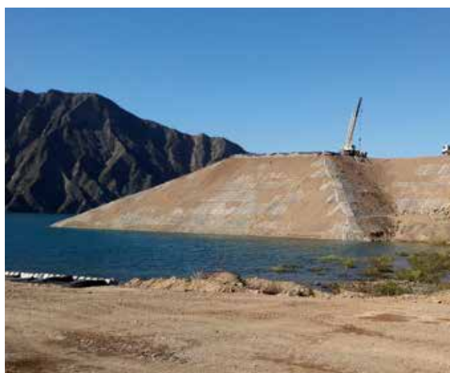
Vista de obra terminada
