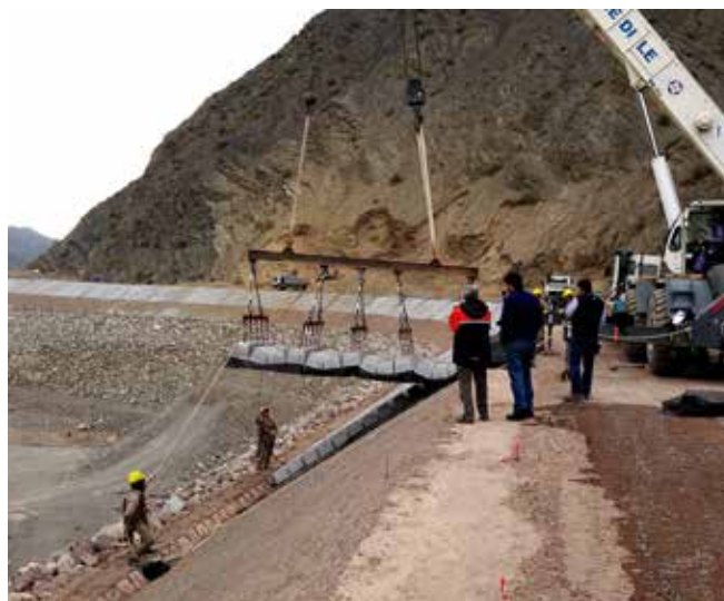
Montaje de mantas sobre el talud
