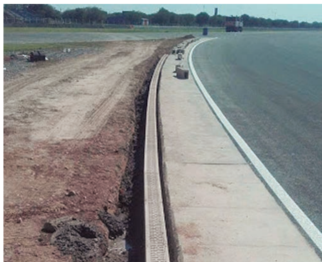
Etapla constructiva, canal ACO® Monoblock PD100.
