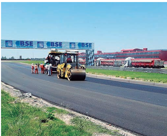
Renovación de carpeta asfáltica.
