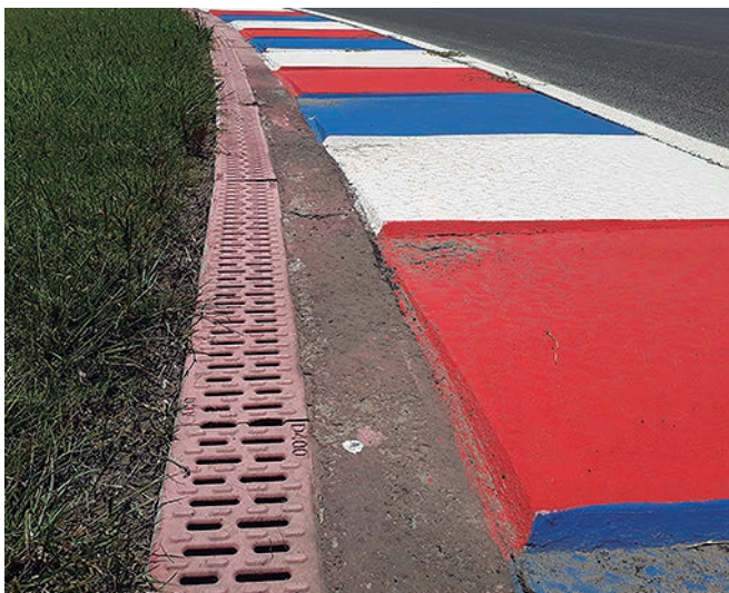
Obra Finalizada, canal ACO® Monoblock PD100.
