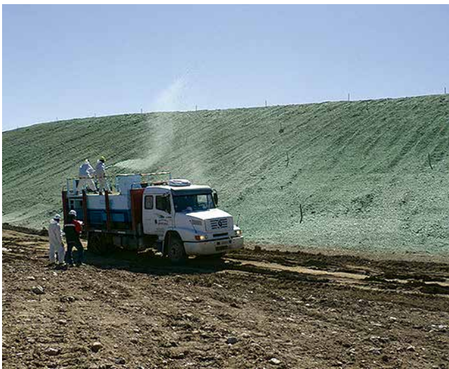
Aplicación de hidrocobertura (mulch Flexterra®).
