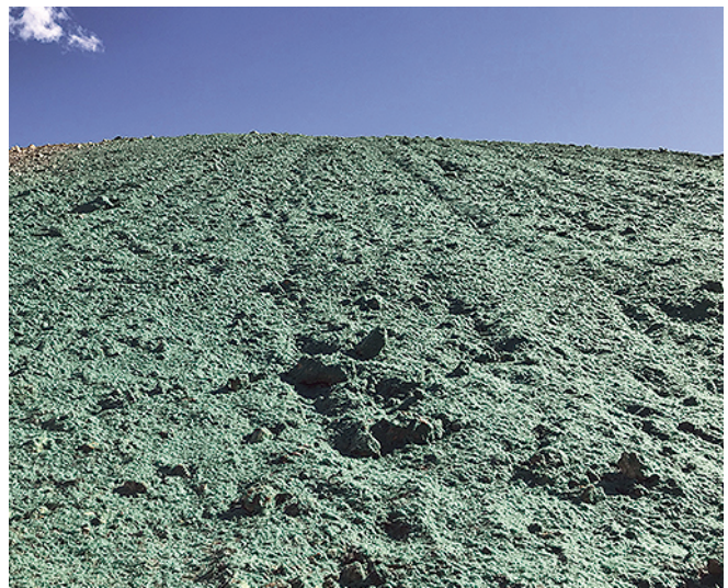
Aplicación de Flexterra® sobre taludes. A las 48 hs el color verde se degrada.
