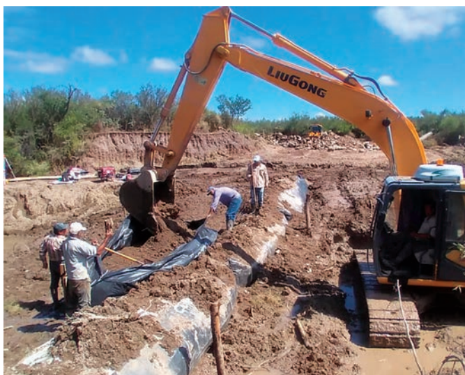
Instalación y relleno de los geotubos
