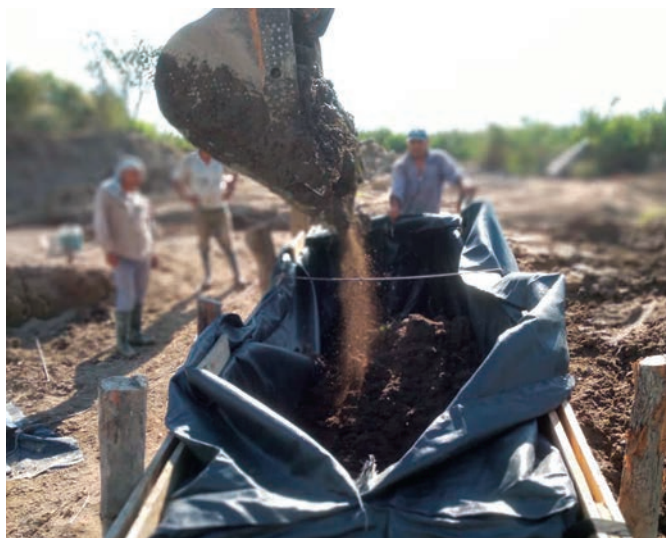
Relleno en seco de los geotubos con material local
