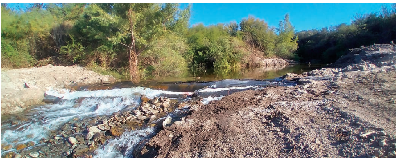
Vista final del azud con geotubos
