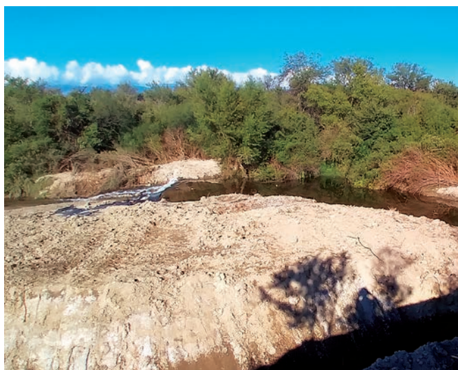
Vista del cierre y la bocatoma del canal
