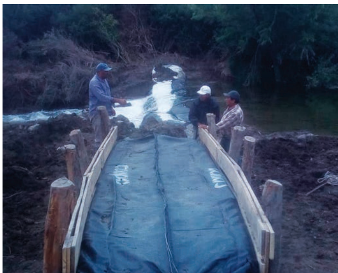
Encofrado simple utilizado para el relleno en seco de los geotubos
