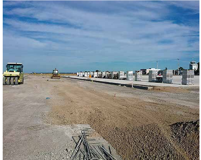
Vista general ampliación de la plataforma y canales ACO.
