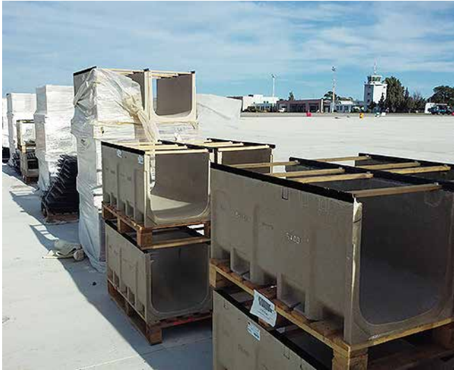
Canales ACO S400 sobre la plataforma.
