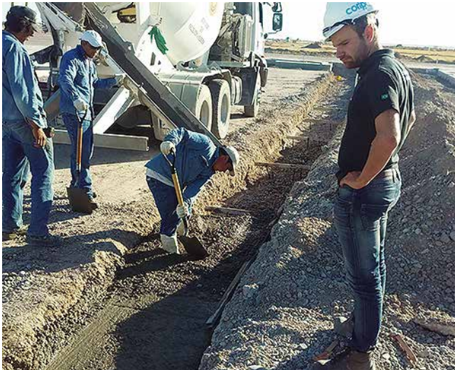
Asistencia técnica durante la instalación de los canales ACO.
