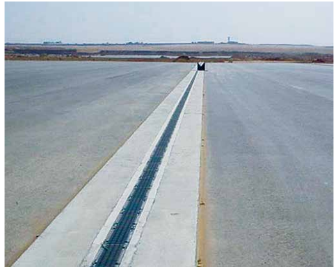
Vista general de canales instalados.
