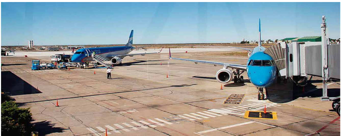
Vista general del aeropuerto de Trelew.
