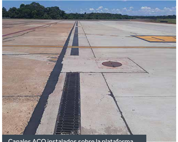
Canales ACO instalados sobre la plataforma
