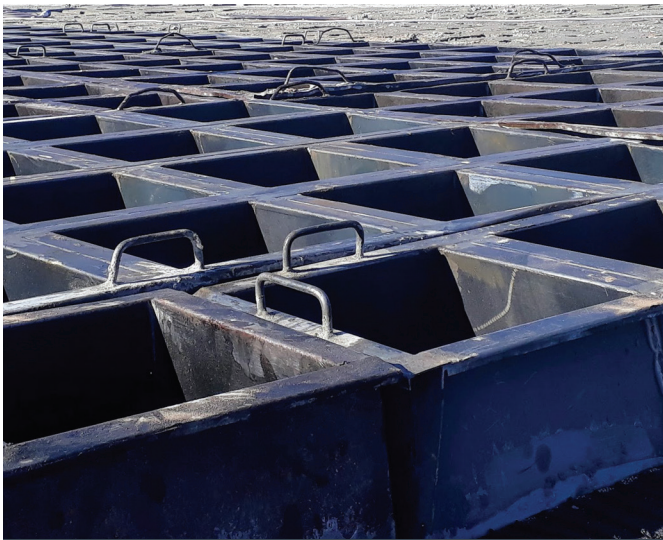
Colocación de geotextil PlusTex® HLT SCL y Moldes.
