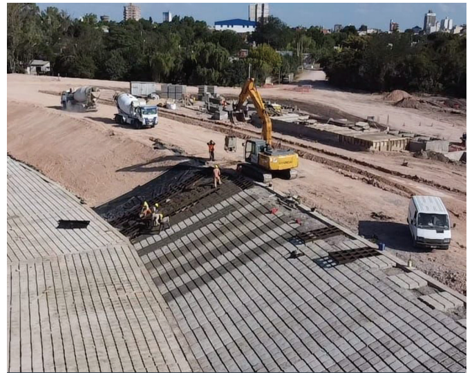
Hormigonado del revestimiento Betonflex®
