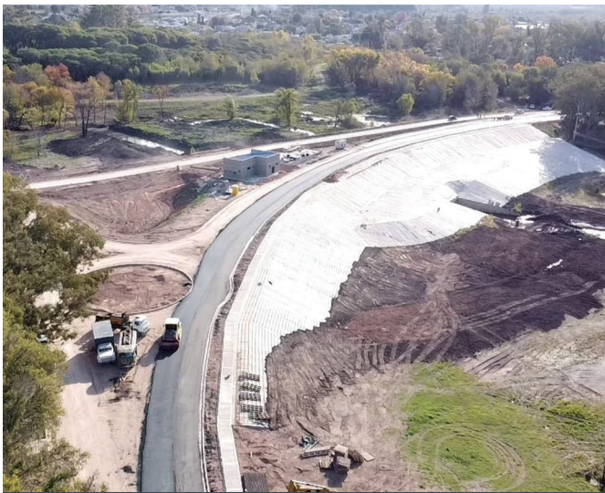
Avance de obra
