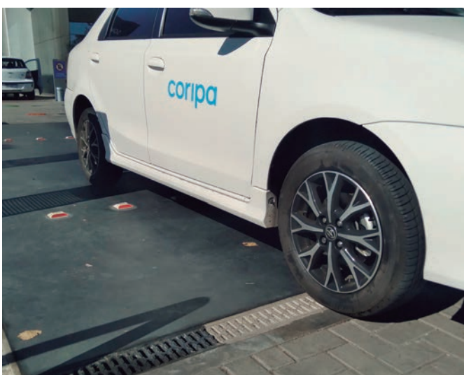
Obra finalizada. Vista de ACO Monoblock instalado
