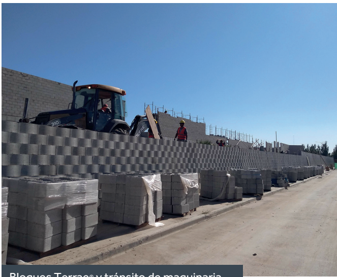
Bloques Terra® y tránsito de maquinaria.
