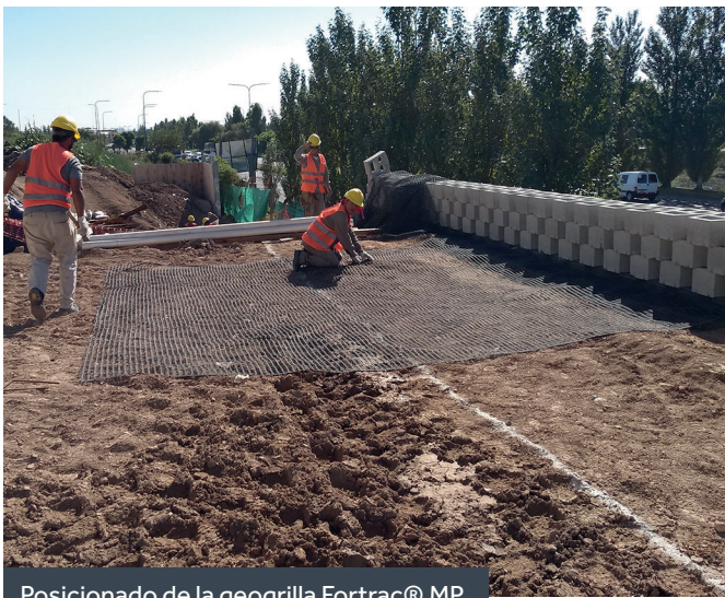
Posicionado de la geogrilla Fortrac® MP
