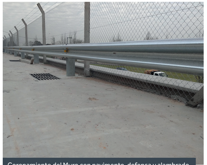
Coronamiento del Muro con pavimento, defensa y alambrado
