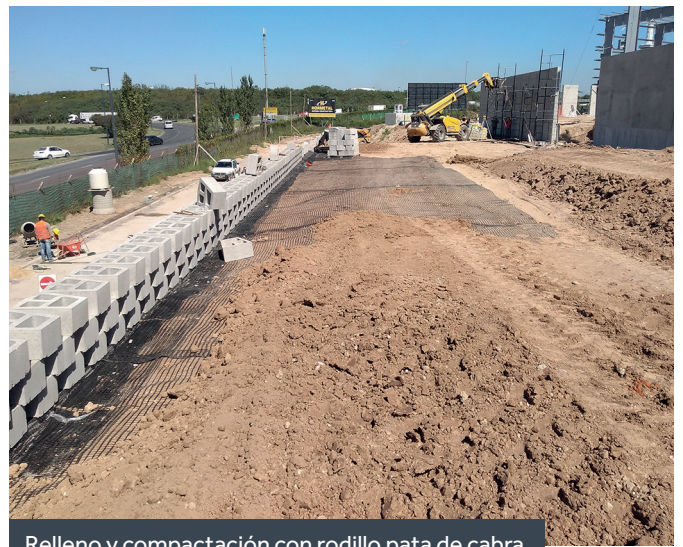
Relleno y compactación con rodillo pata de cabra
