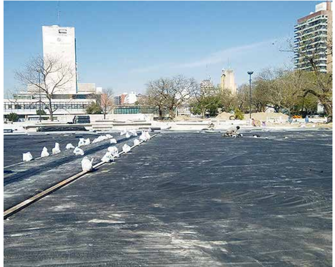
Colocación de la geomembrana Flexplan.
