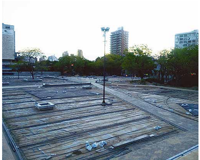
Sistema de riego colocado sobre la superficie impermeabilizada.
