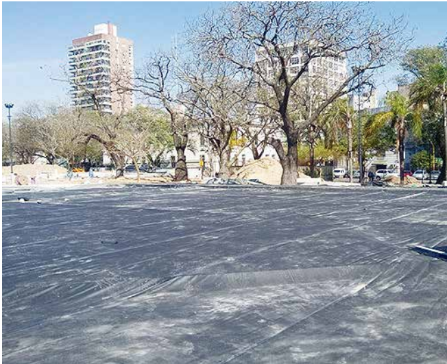
Geomembrana Flexplan colocada.
