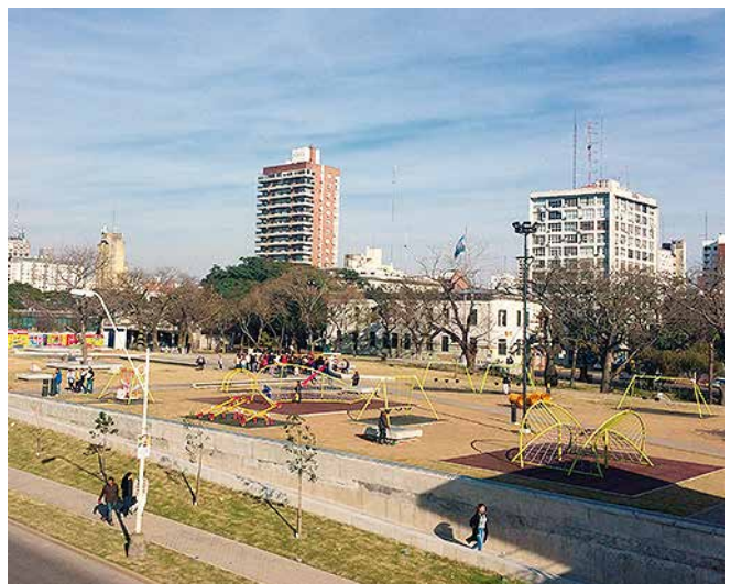
Vista general del Parque con obra finalizada.
