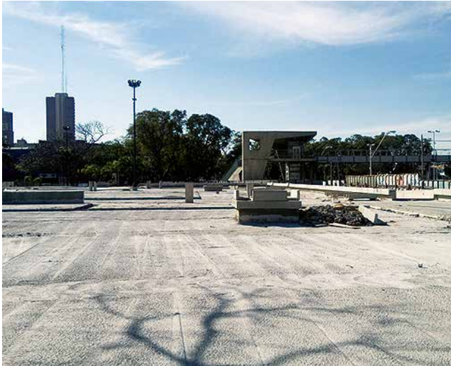
Superficie a impermeabilizar.
