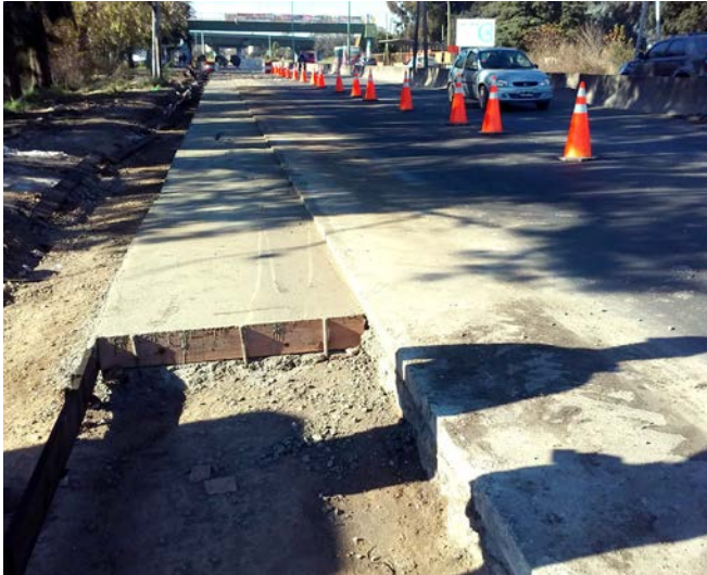
Ampliación - Banquina de Hormigón.
