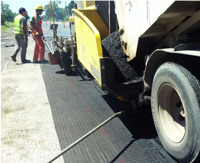
Pavimento sobre grilla.
