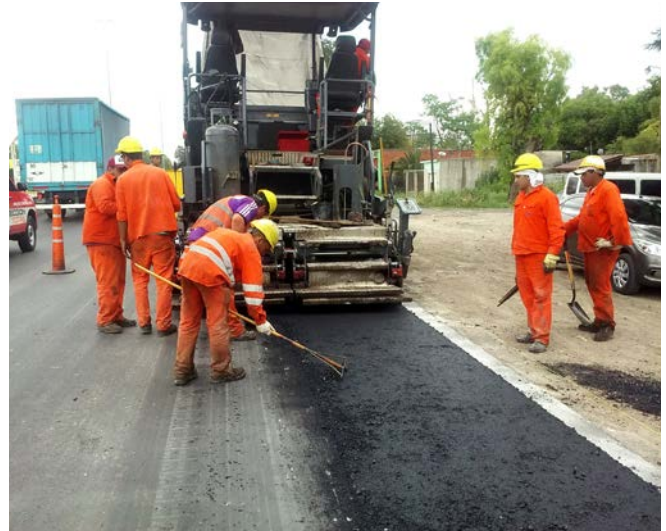
Pavimento sobre grilla.
