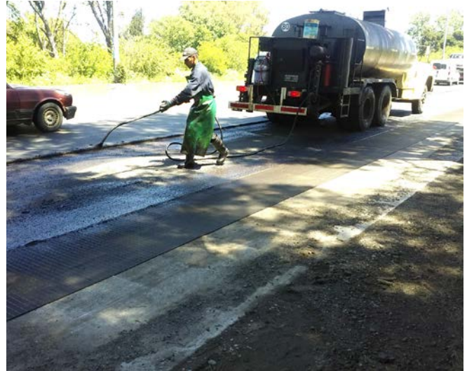
Instalación de grilla Samigrid®. Riego de liga.
