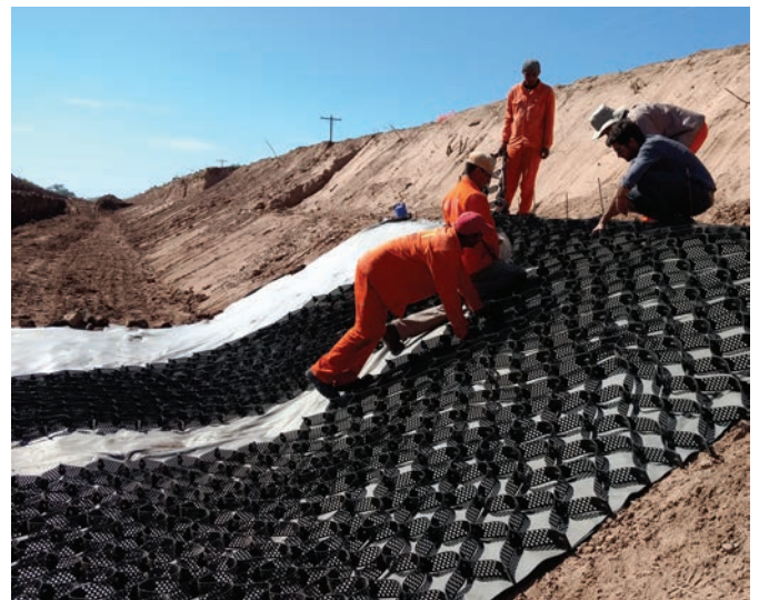
Vinculación y anclaje de paneles PlusWeb®
