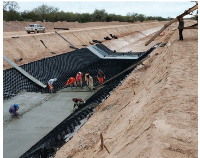
Avance de obra
