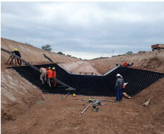
Despliegue de los paneles PlusWeb®
