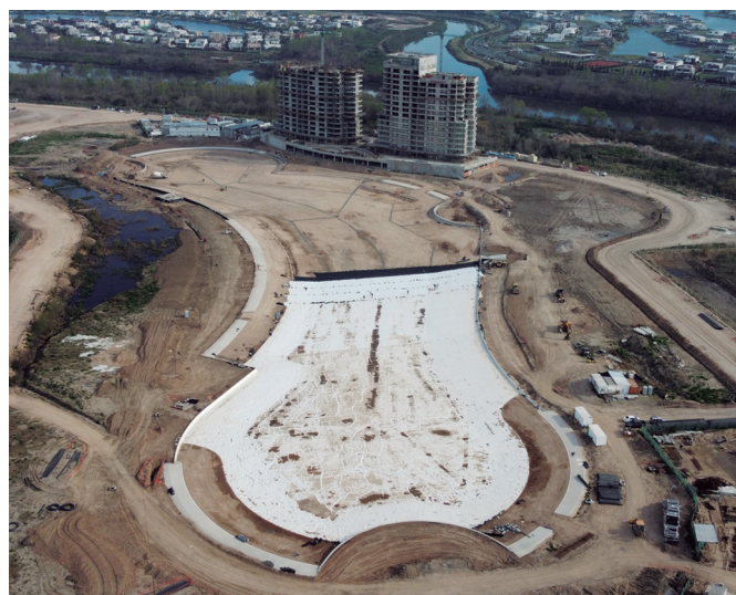
Vista general de la obra
