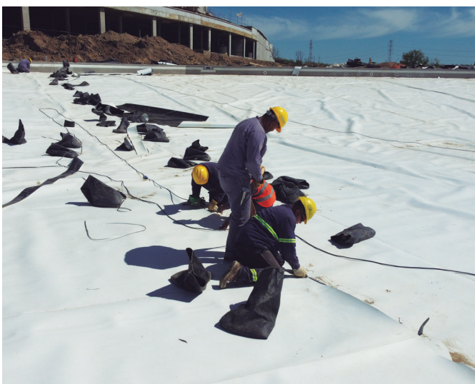
Soldadura por termofusión de PlusTene®
