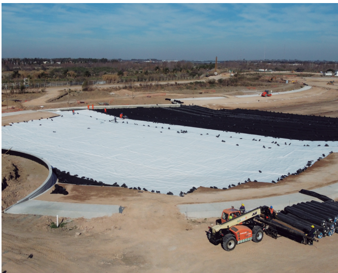
Inicio de obra – Vista Paquete impermeabilizante
