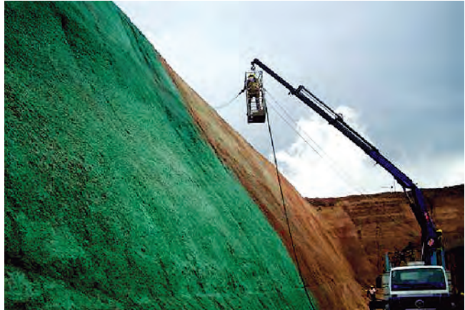
Aplicación de la hidrocobertura.
