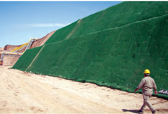
Geomanta colocada sobre la hidrocobertura.
