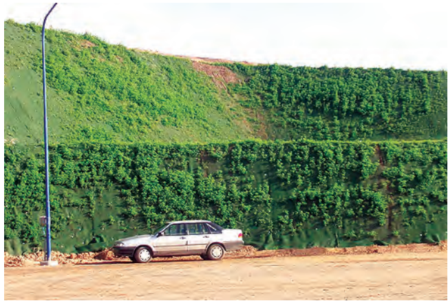
Inicio de la vegetalización del revestimiento.
